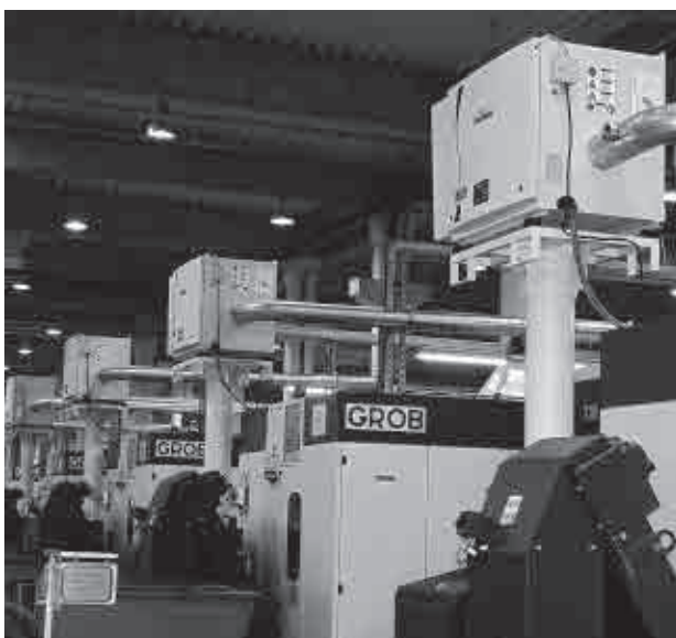
Un filtro -una macchina Installazione presso Premium Aerotech, A•mist 10C
